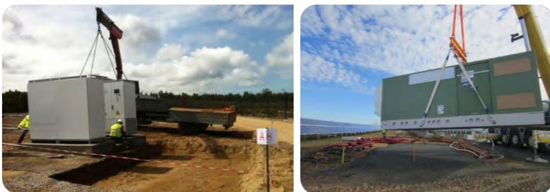
Installation de postes de conversion
