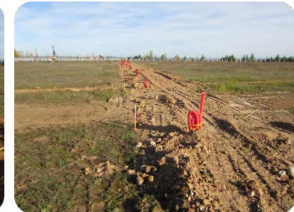
Création des tranchées
