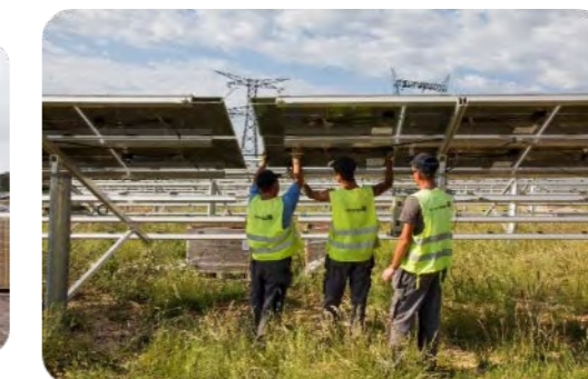
Pose de modules
