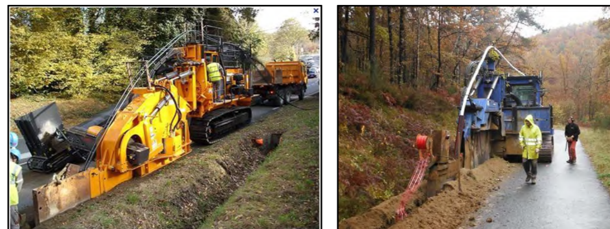
Trancheuse | Exemple de pose de câble à la trancheuse Source : NEOEN
