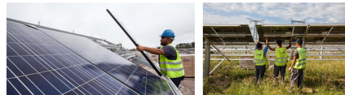
Pose de modules
