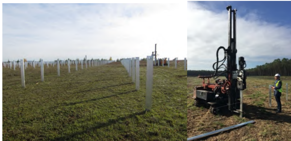
Exemple de pieux battus dans le sol et batteuse
