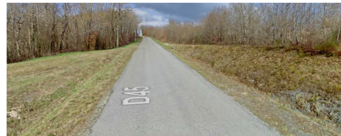
Vue depuis la RD45 au niveau du tracé de raccordement envisagé
