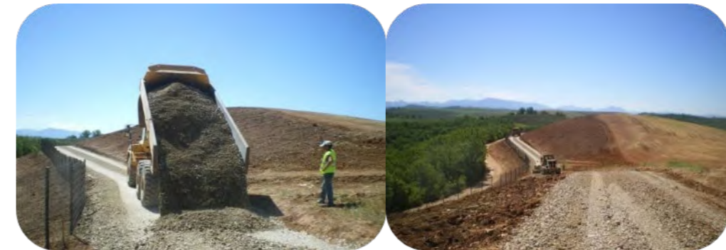
Création des pistes lourdes (source Neoen)
