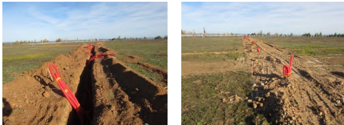
Exemple de tranchée et pose de câbles dans des fourreaux
