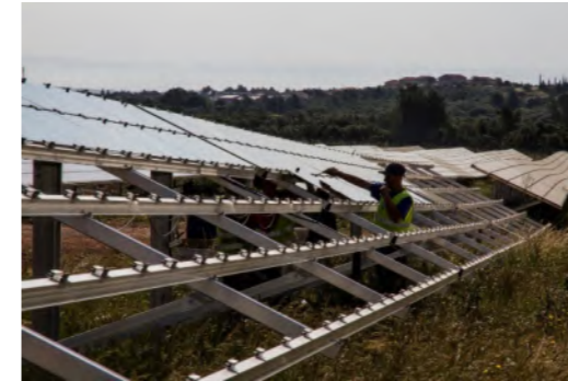
Montage des structures supports (source : NEOEN)
