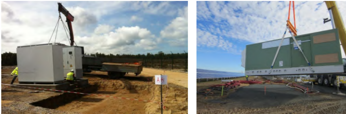
Exemple d'installation de poste de conversion
