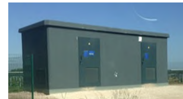
Exemple de poste de livraison (source : NEOEN)
