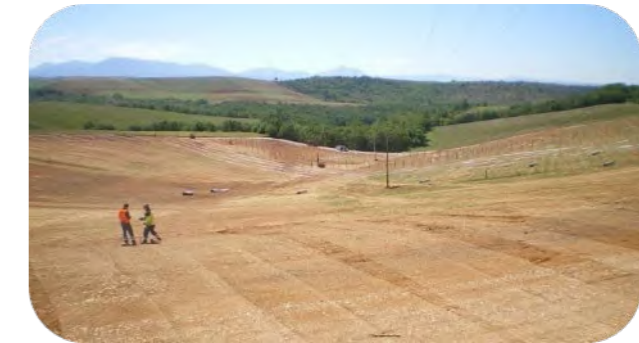
Piquetage (source : Neoen)
