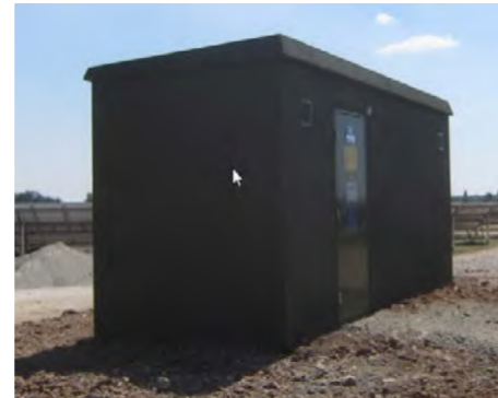
Exemple de poste de conversion « indoor » (source : NEOEN)
