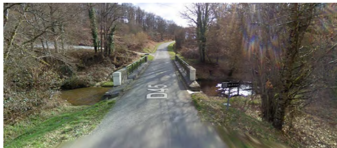
Traversée de la Brame par encorbellement
