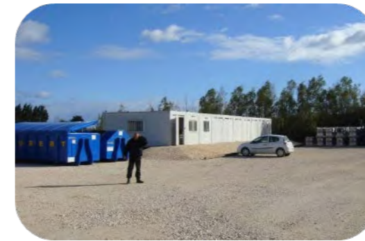
Mise en place de la base de vie
