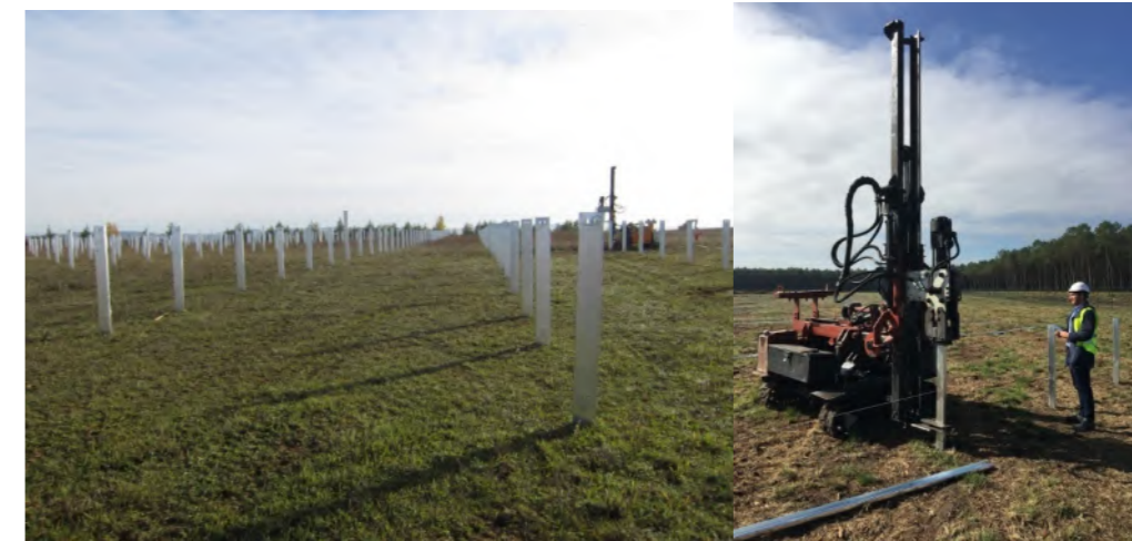
Exemple de pieux battus dans le sol et batteuse
